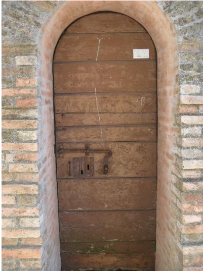
Quadro Q07.1: Su campanile Chiesa Merlengo
