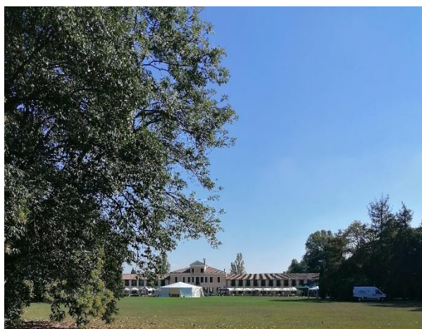
Il complesso edilizio "Relais Monaco" (vista da nord)
