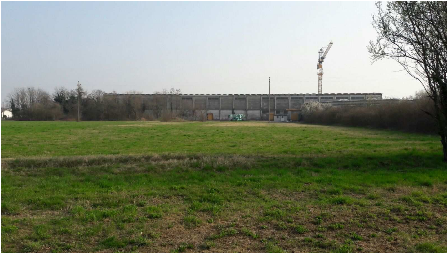
Foto stato di fatto
