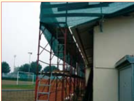
La situazione del magazzino comunale durante i lavori
