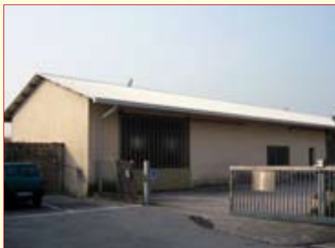
Dopo l'intervento sul tetto
